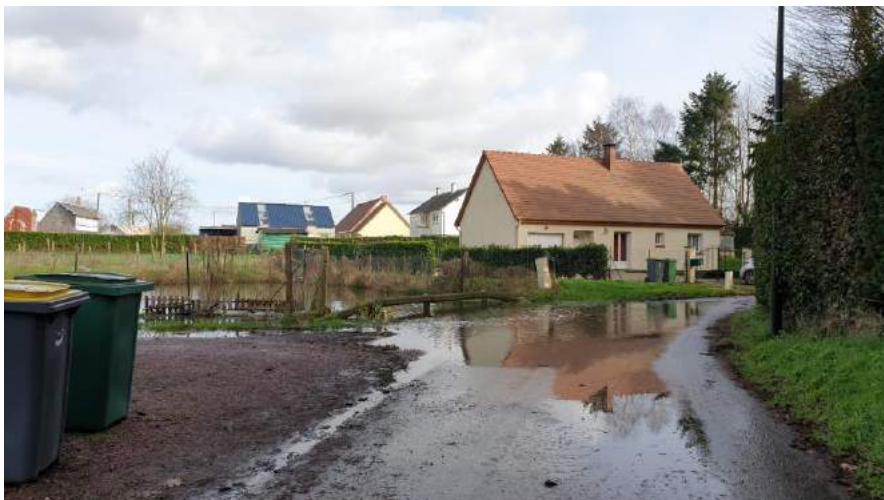
Inondation constatée en février 2020 – secteur des Marais
